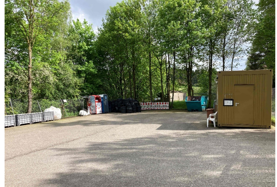
RecyclingCenter Altheim ( Containersituation und Personalbereich)
